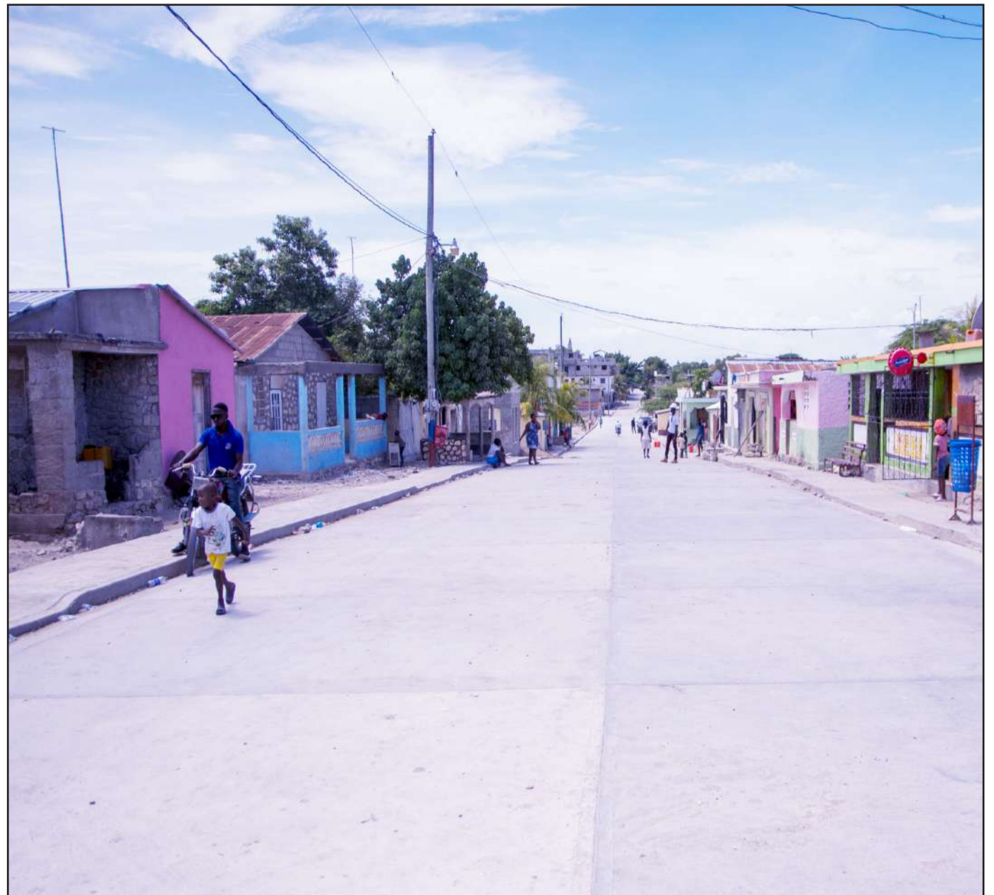
Bétonnage de routes, dans le cadre des petits projets réalisés par le FAES
