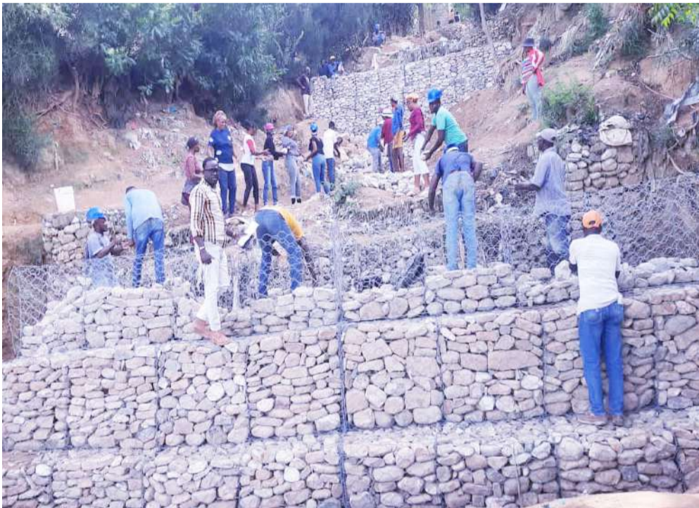
Construction d'un escalier de 92 mètres linéaires en maçonnerie de roches et de 20 mètres linéaires de mur de soutènement à la Rue Pidis/Bois du Lac, au cœur du centre-ville de la commune de Port-de-Paix.
