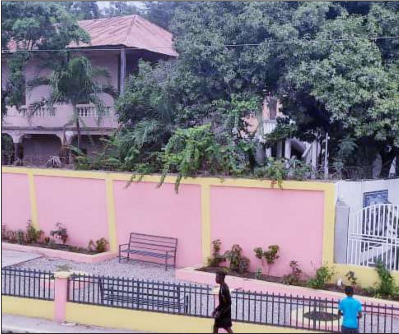
Construction d'une place publique, financée par la BID, à la rue Monfort, commune de Port-de-Paix
