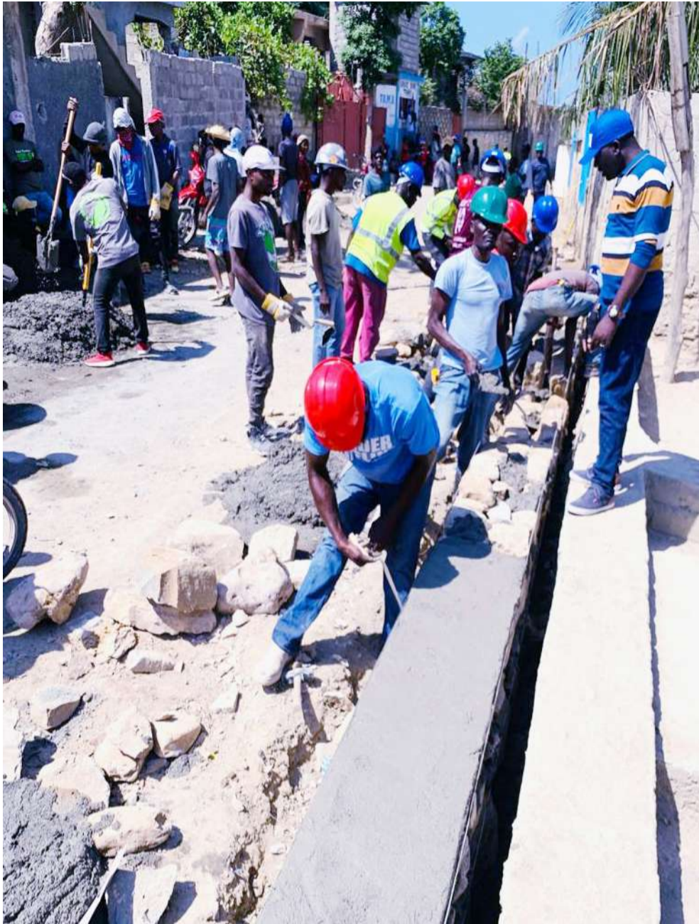
Réalisation de mur de soutènement à Armand dans le Nord-Ouest
