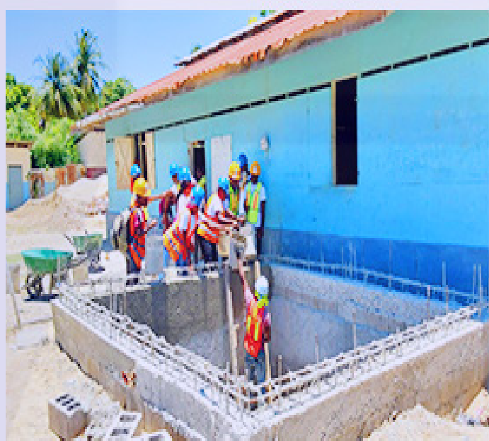
Avancement du chantier à Lilavois HA-J0005
