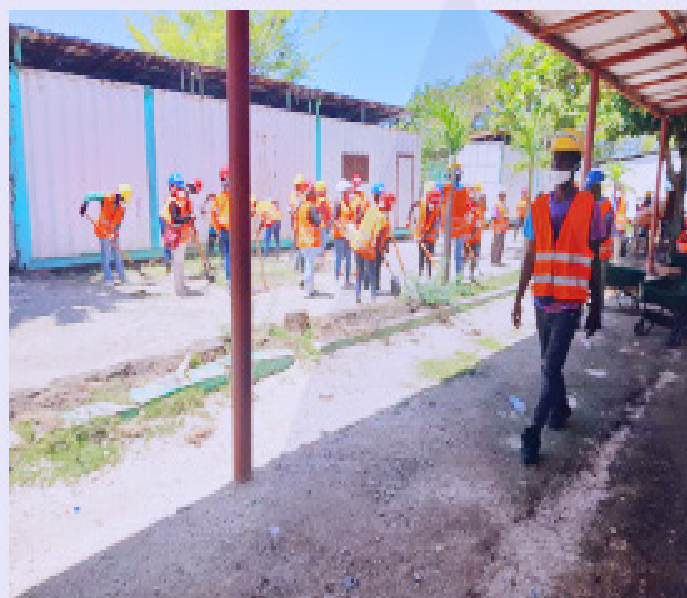
Le Projet de Réhabilitation de l'hôpital Ste Marie progresses considérablement / HA-J0005
