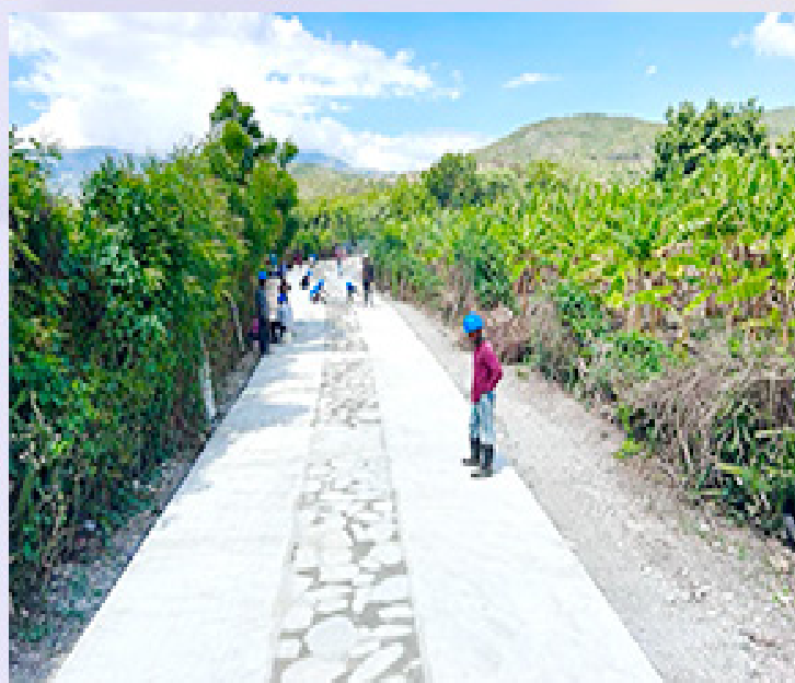
Travaux de Bétonnage de Morne Damas à Des- roulin à Bassin Blue, Nord-Ouest / HA-J0005
