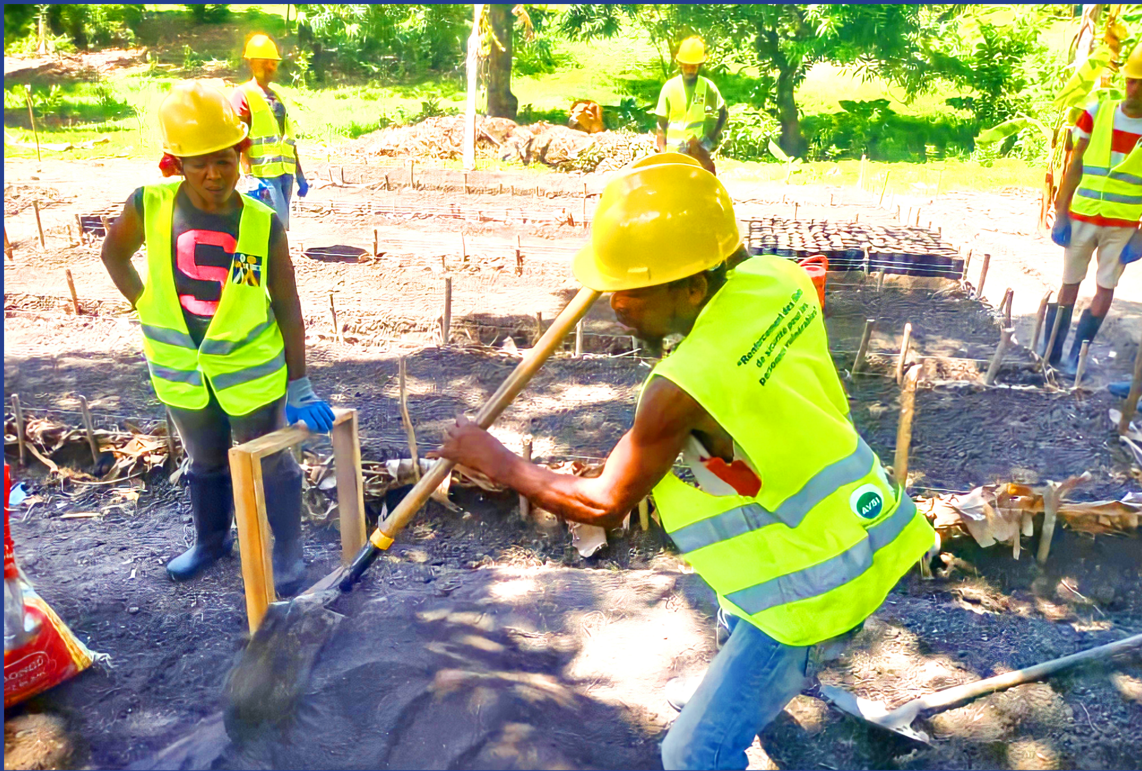
Construction d'une pépinière à Coteaux, localité de la Commune de Saint-Jean du sud
