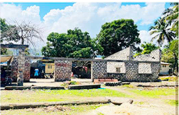
Projet de réhabilitation du centre professionnel de Kethan évalué / Nippes / HA-J00007
