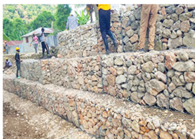
Gabionage à la Source dans le Nord-Ouest, CARE
