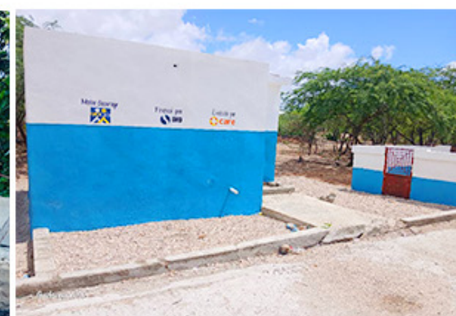
Réhabilitation du point d'eau de Bois d'Homme Baie-de-Henne / Nord-Ouest CARE
