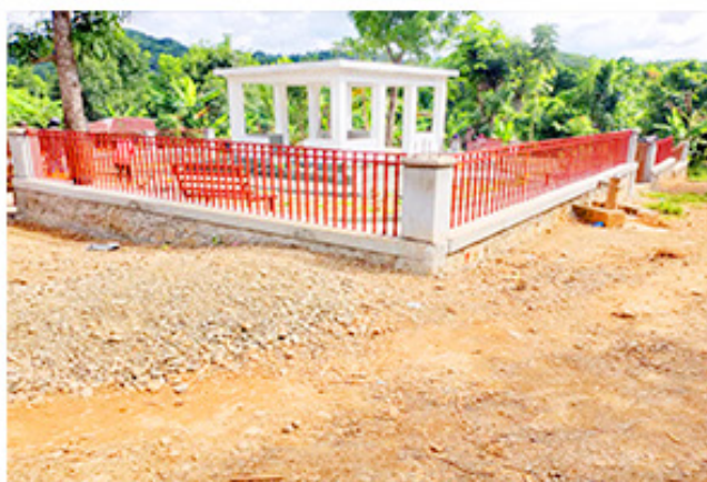
Construction de la place publique Nan Franklin, Anse d'Hainault , PADF
