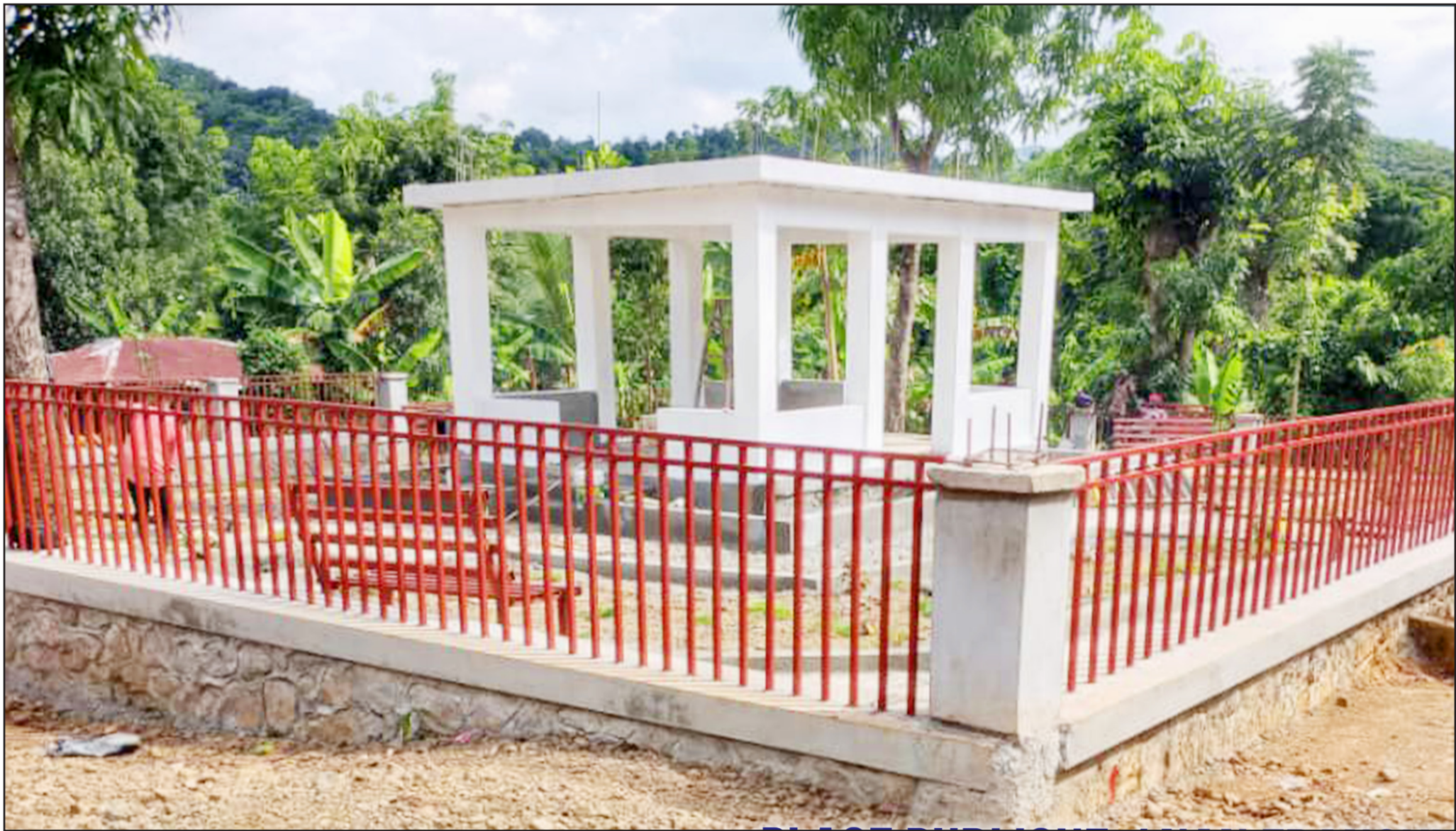
Construction d'une place publique à Nan Franklin, Anse d'Hainault, Grand'Anse. Crédit Photo : PADF
