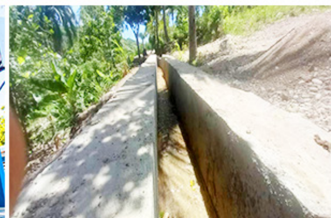
Réhabilitation de Canaux d'irrigation, Baie-de-Henne, Nord-Ouest , CARE
