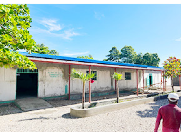
Réhabilitation de l'Hopital Ste Marie, Cité Soleil OUEST, PADF
